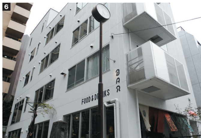
写真6 ターンテーブルの外観。建物右手に広がる区立公園との連続性を確保し、開放感を取り込むため、敷地境界のブロック塀を取り払った。
