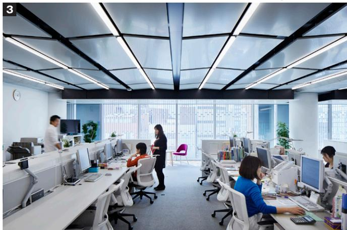
写真3 放射パネルでの反射や全体に白を基調としたインテリアで明るさが増す造り。設計上の想定で机上面照度は300ルクスと低めだが、一般のオフィスと同等の明るさを感じるという。
